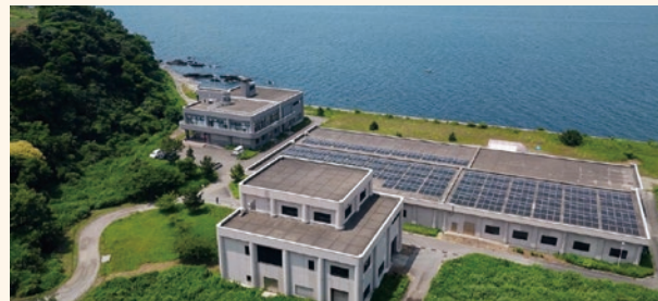
三浦市公共下水道(東部処理区)運営事業 (2023年4月より当社グループ等から構成されるコンソーシアムによって運営開始)
