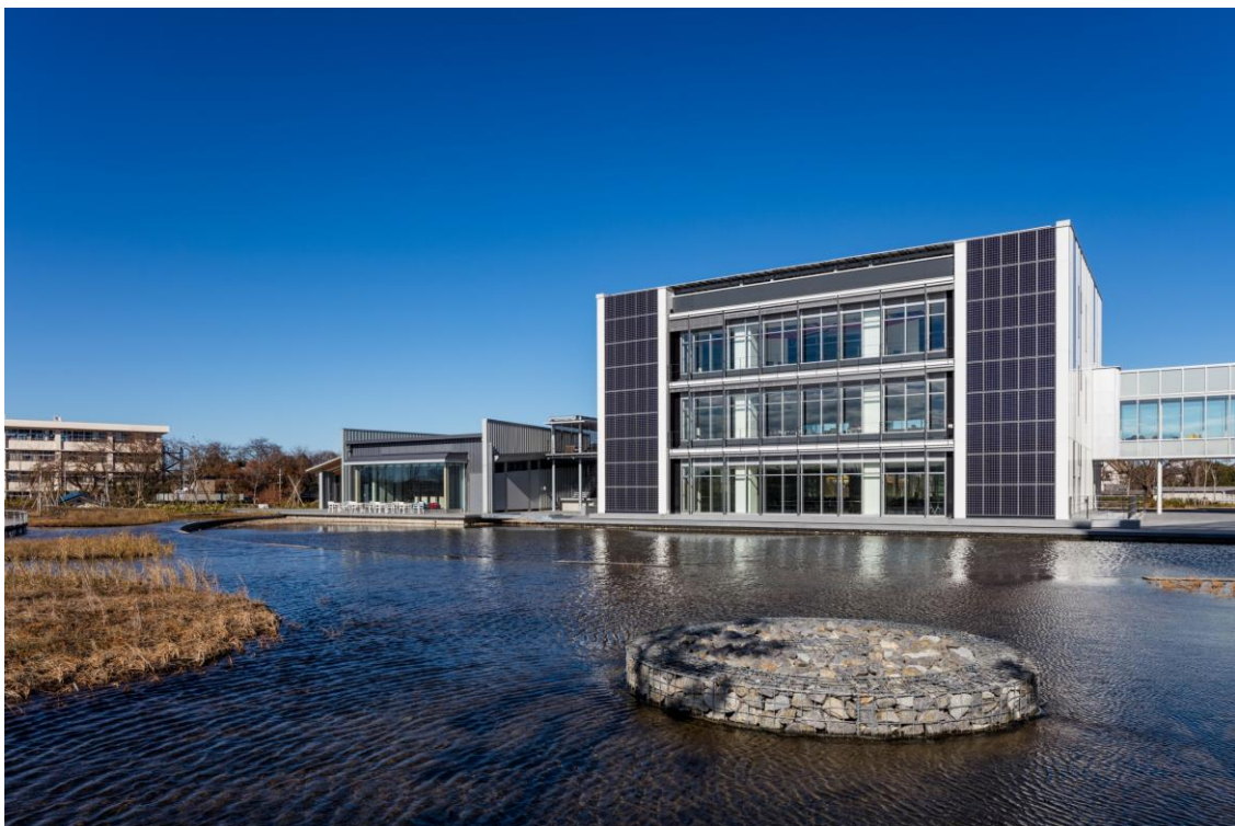
ICI Lab エクスチェンジ棟
