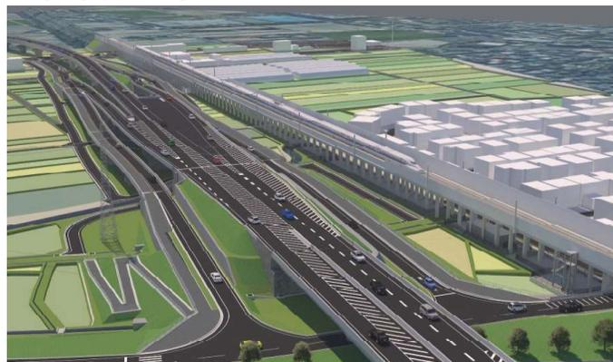
野洲栗東バイパスは、国道8号の野洲市から栗東市間の交通混雑の緩和を目的として、昭和57年度に事業化した延長4.7kmの道路。本線及びONランプ、OFFランプの上部工を構築する工事である。
