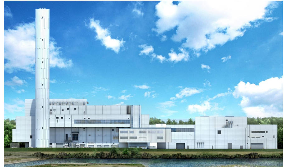
高浜クリーンセンター新設工事
