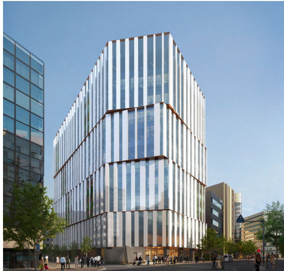
福岡東総合庁舎敷地オフィスビル (仮称) 新築工事
