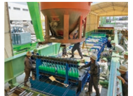
プレストレス道路床版試作状況
