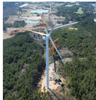
風車施工の様子
