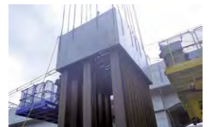
REED工法施工状況
