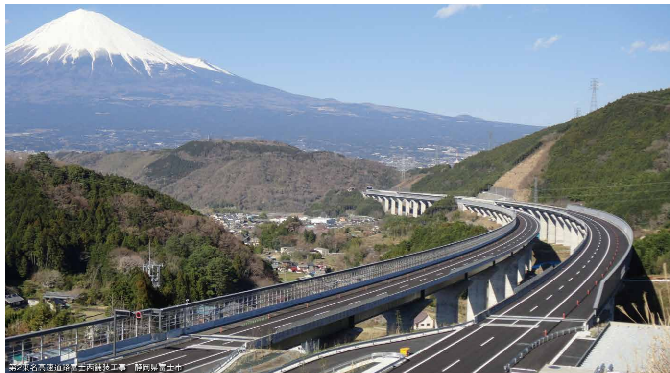
第2東名高速道路富士西舗装工事 静岡県富士市
