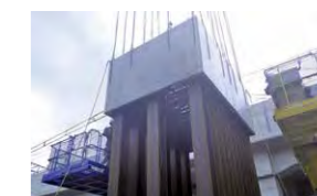
REED工法施工状況
