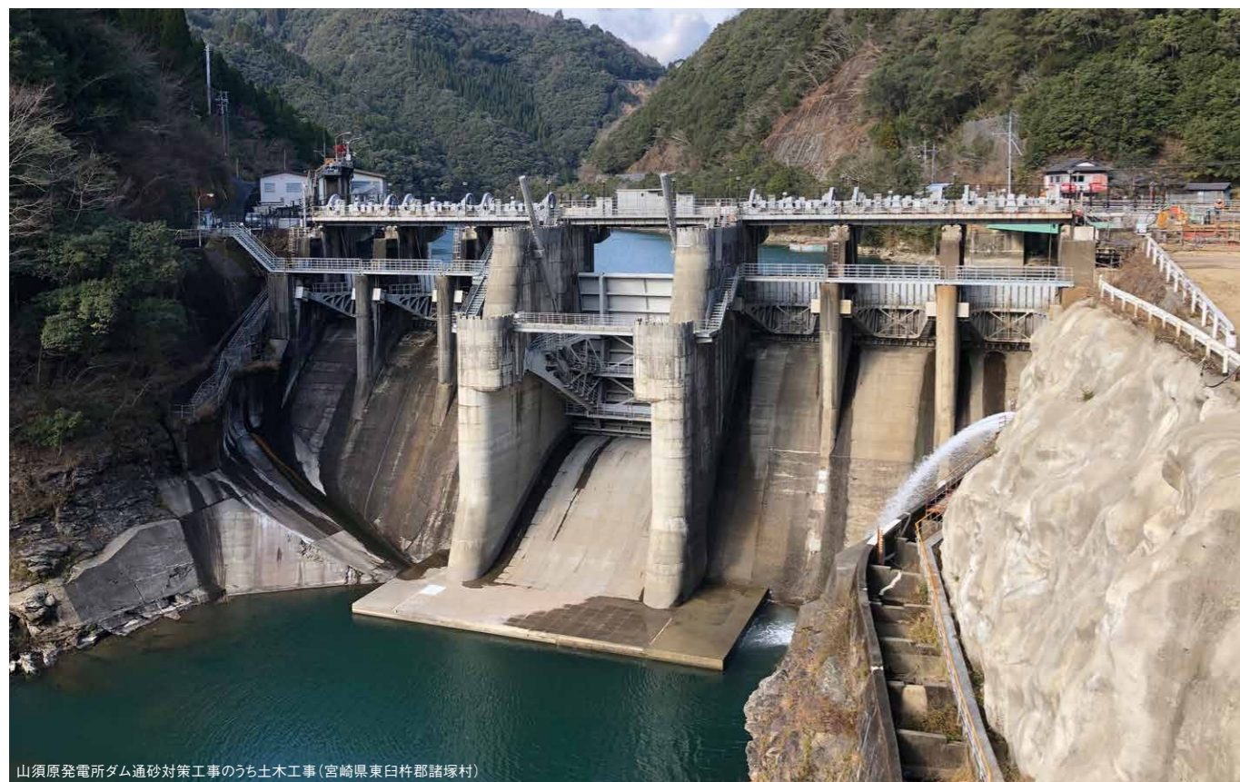
山須原発電所ダム通砂対策工事のうち土木工事(宮城県東白村郡諸塚村)
