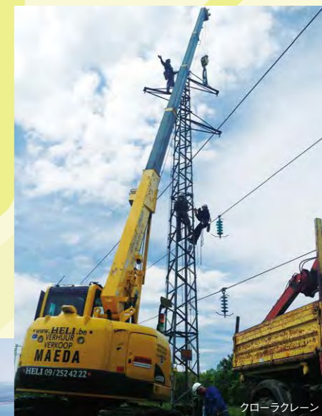
クローラクレーン
