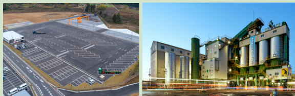
(仮称)ヒロセ関東新工場プロジェクト 朝霞合材工場
