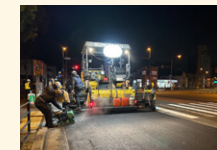
前田道路「環境配慮型舗装ecole」
