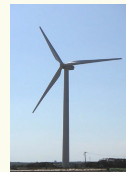
日本風力開発が運営する 銚子小浜風力発電所(卒FIT)
