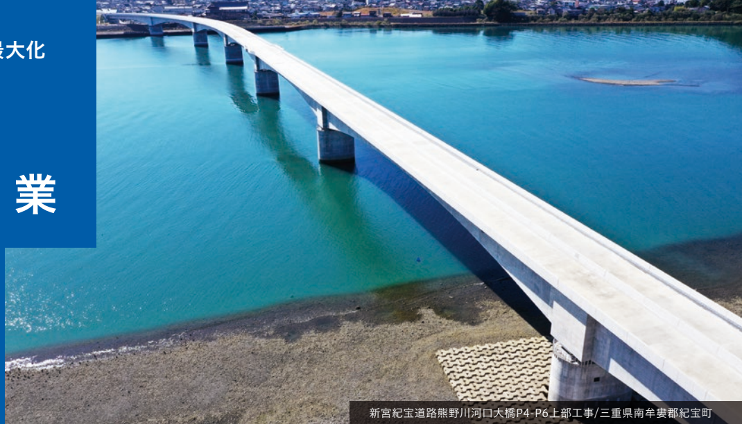
新宮紀宝道路熊野川河口大橋P4-P6上部工事/三重県南牟婁郡紀宝町
