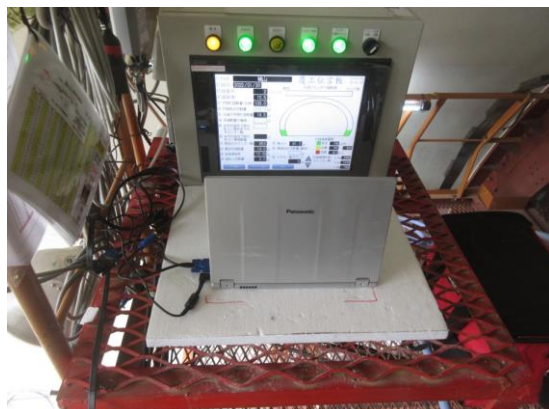
覆工伝言板設置状況
