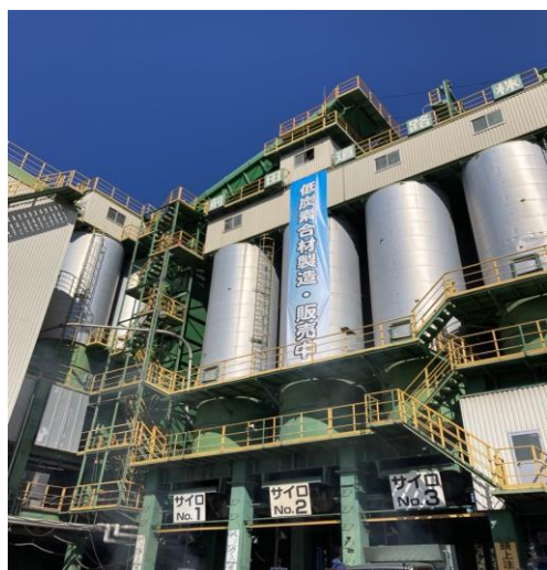
前田道路 朝霞合材工場
