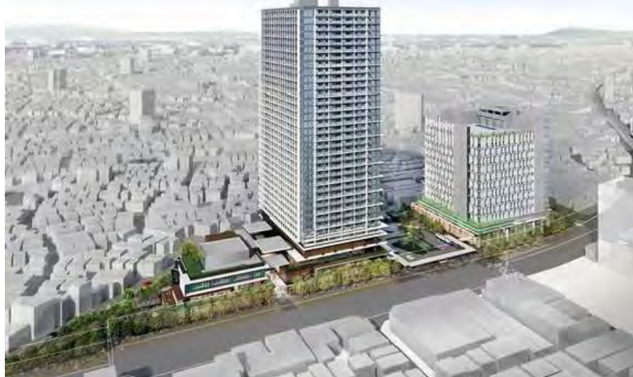
立石駅北口地区第一種市街地再開発事業（西街区）
