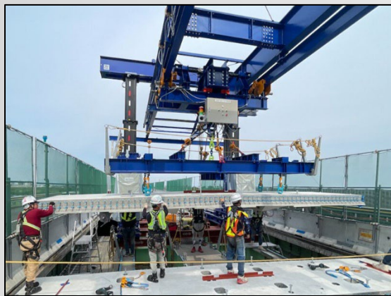
名神高速道路 長良川橋(施工中) 床版取替工事
